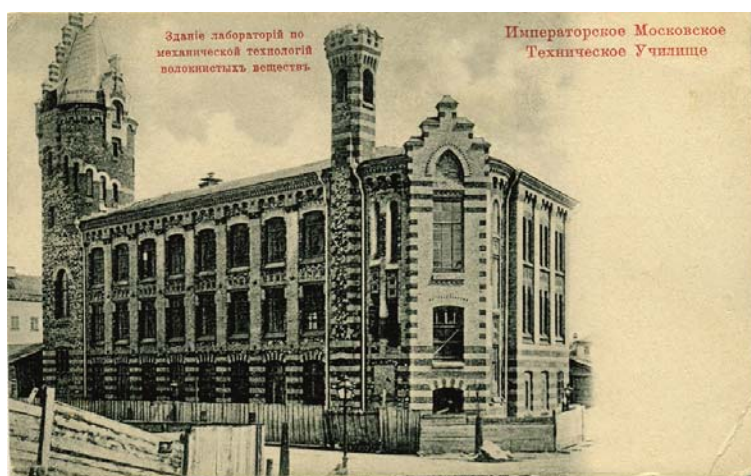
Рис. 5. Строительство здания Лаборатории механической технологии волокнистых веществ 2
