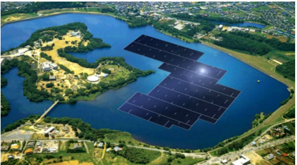
Рис. 1. Изображение одной из плавучих солнечных электростанций в Японии на водном пространстве территориального озера
