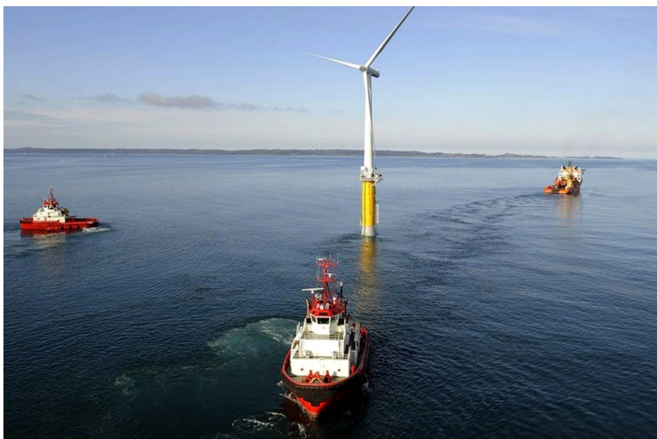
Рис. 3. Плавучая ветровая установка Hywind (разработка компаний Siemens и Technip). Момент установки для тестирования [12]
